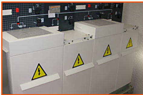
Instalación de electricidad en media tensión
